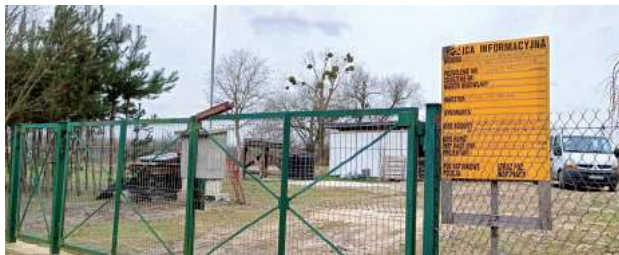
To na tej działce powstaje wieża telefonii komórkowej. O prowadzonej inwestycji można dowiedzieć się m.in. z umieszczonej na niej tablicy informacyjnej
