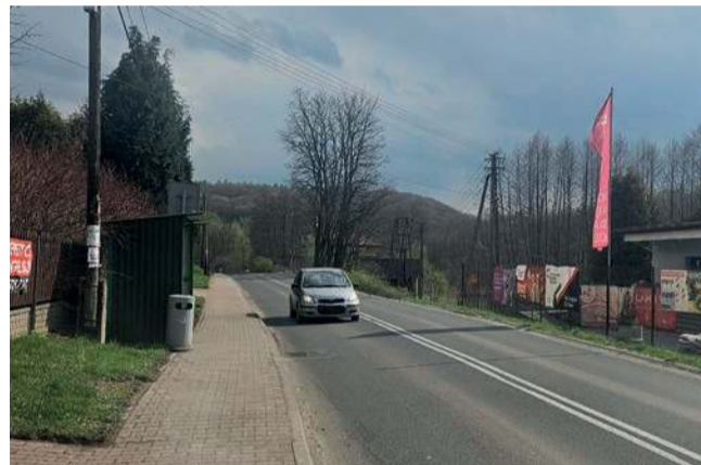
Przystanek autobusowy na ul. Chrzanowskiej w Regulicach. Na razie jest tylko po jednej stronie drogi
