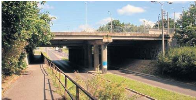
Drogowy wiadukt nad ulicą Brzechwy wybudowano wraz z kolejowym na początku lat 80. XX wieku
