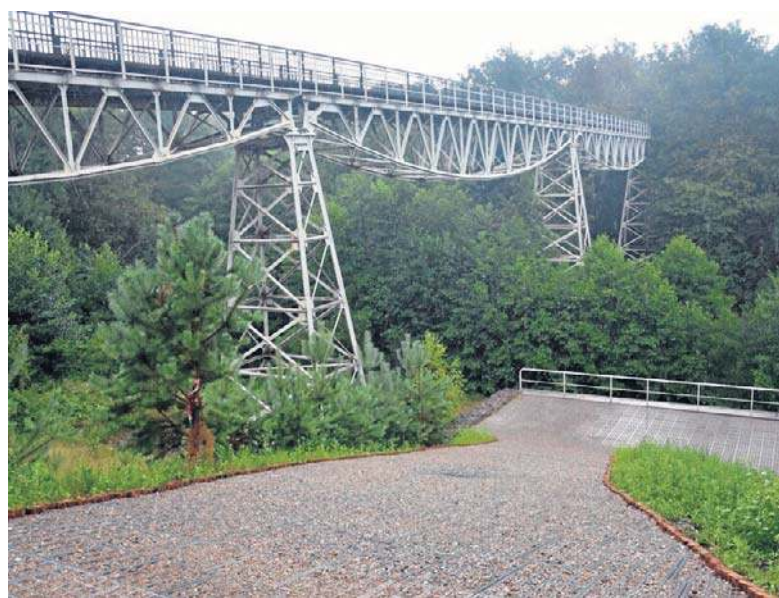
Osuwisko przy zabytkowym moście dawnej kolejki wąskotorowej w Koronowie zlikwidowane. Bariery zakazujące wstępu zniknęły. Znowu można zejść na taras widokowy, by podziwiać most i koryto Brdy
