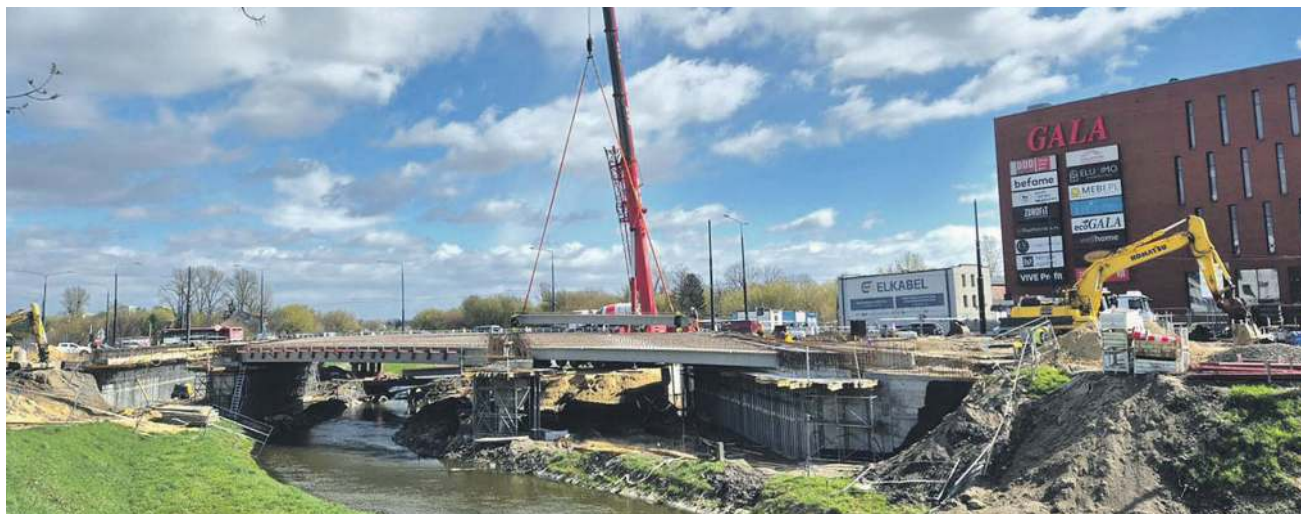
Obecny etap remontu to montaż wielkogabarytowych dźwigarów
