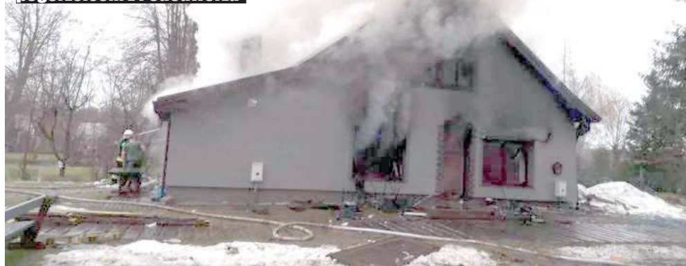
Dramat rozegrał się pod koniec lutego. Budynek trzeba rozebrać - nie nadaje się do remontu
