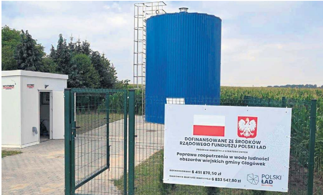
Zbudowano 11 km nowej sieci wodociągowej, duży zbiornik retencyjny i pompownię strefową.
