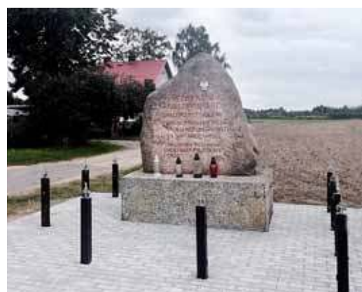
Obelisk z 1992 r. w trakcie renowacji
