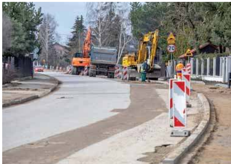
Jedna z tegorocznych płońskich inwestycji – modernizacja ul. Szkolnej
