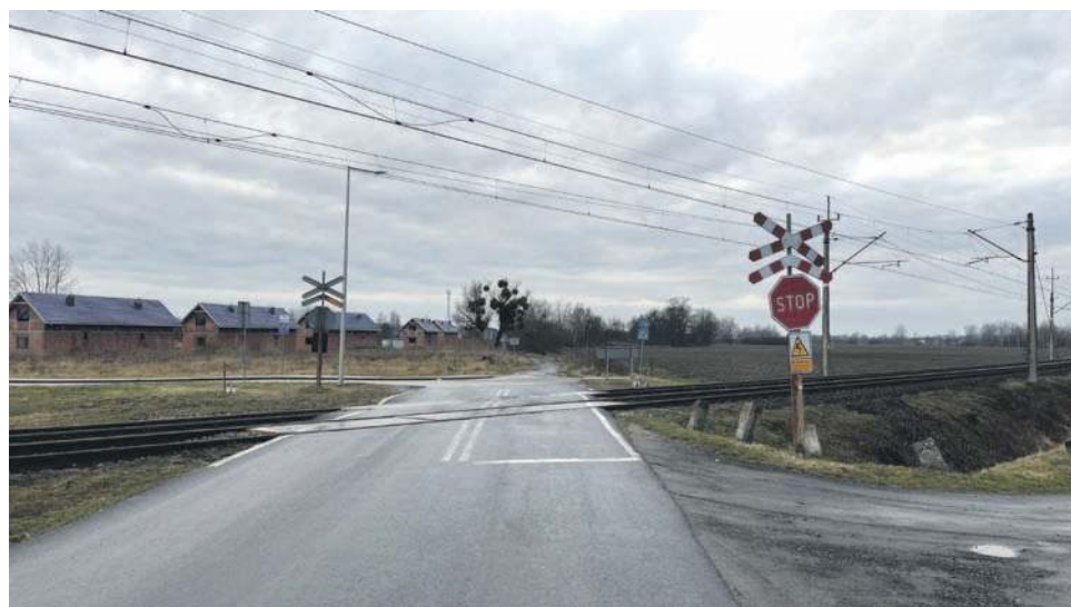
Ten przejazd potrzebuje modernizacji
