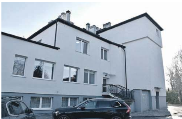
Nowe okna już są
