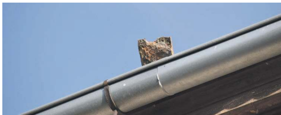
Kruszące się dachówki spadają na ziemię albo zatrzymują w rynnach co stwarza jeszcze większe zagrożenie
