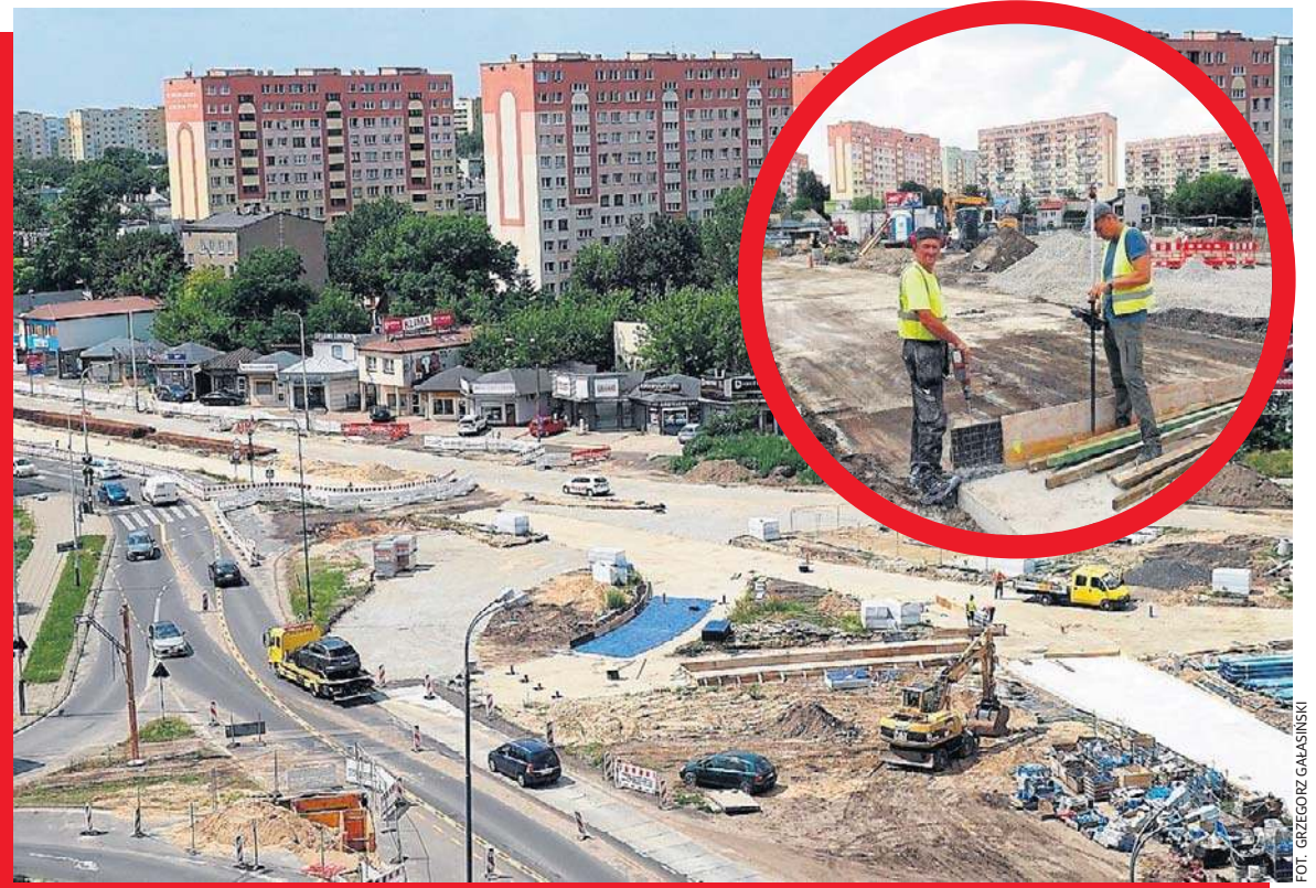
Na ul. Broniewskiego drogowcy wylewają beton, na którym ułożą torę nowej linii z Dąbrowy na Chojny.
