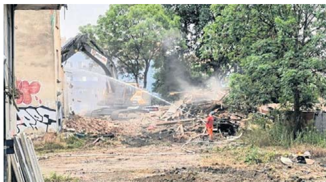
Polewanie rozbieranych ścian wodą niewiele daje
