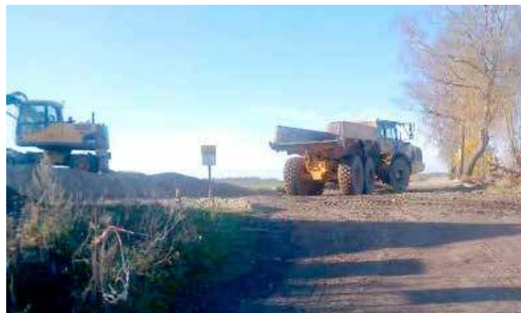
Już budują drogę dojazdową do fermy
