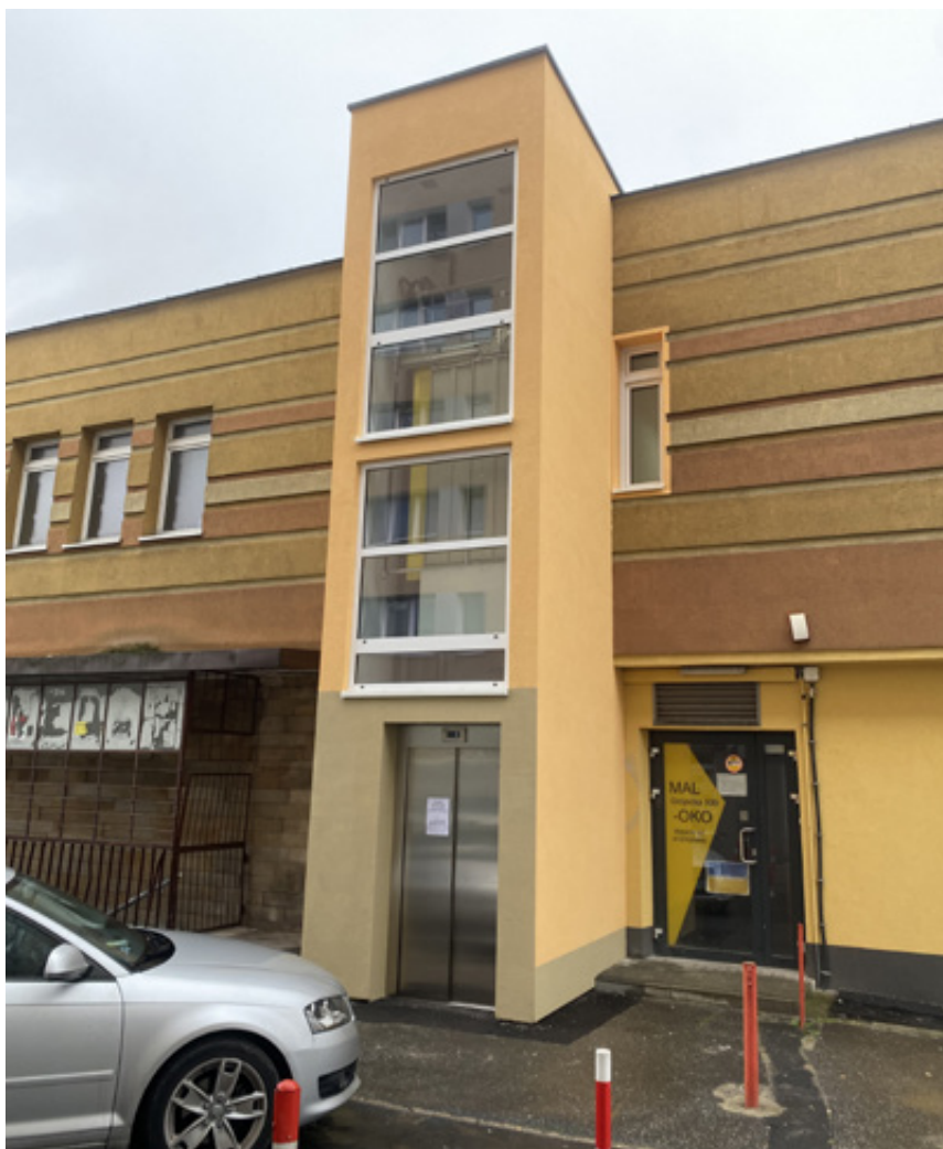
Fot. Dobudowa szybu częściowo przeszklonego do budynku biblioteki przy ul. Grójeckiej 109 w Warszawie
