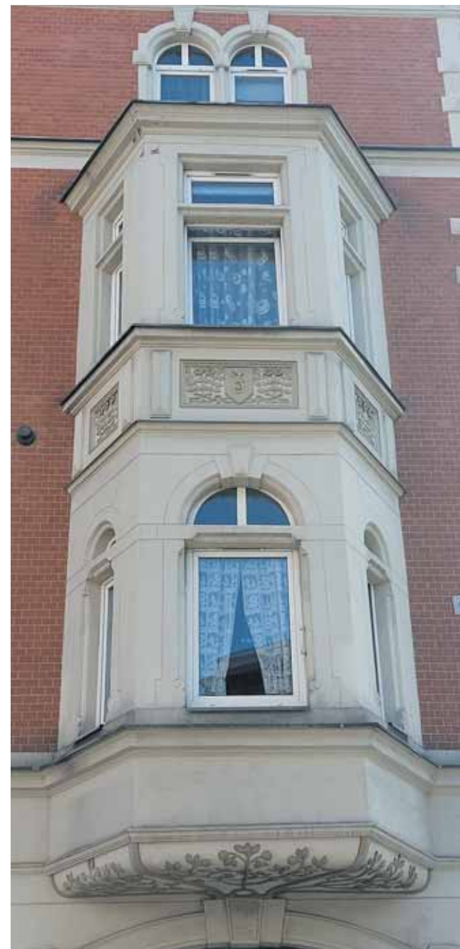
Najbardziej charakterystycznym elementem pozostaje prawa oś fasady zaakcentowana ryzalitem oraz spiętrzoną wykuszą
