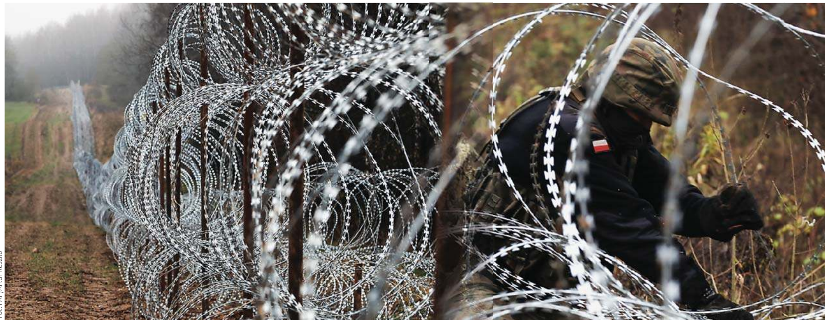
Zapora powstanie na całej długości granicy z Rosją, czyli na odcinku 210 km.
