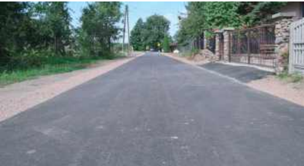
Na całym odcinku powstała nowa konstrukcja jezdni asfaltowej. Wykonano również pobocza
