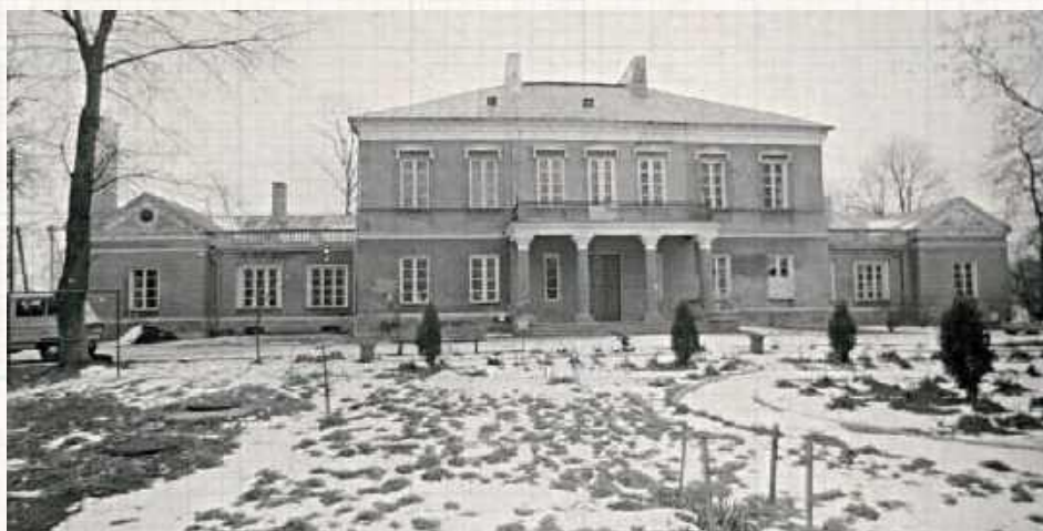
Stan zachowania głównego korpusu pałacu w Olesinie w roku 1979, zdj. K. Bajera - Kojder w karcie zabytku w dokumentacji konserwatorskiej na stronie zabytek.pl
