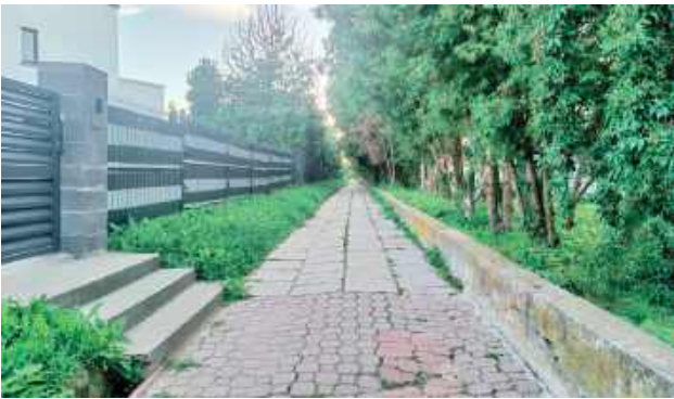
Jeszcze tej jesieni zdeformowane płyty chodnikowe zastąpi chodnik z nowej kostki brukowej oraz asfaltowa ścieżka rowerowa
