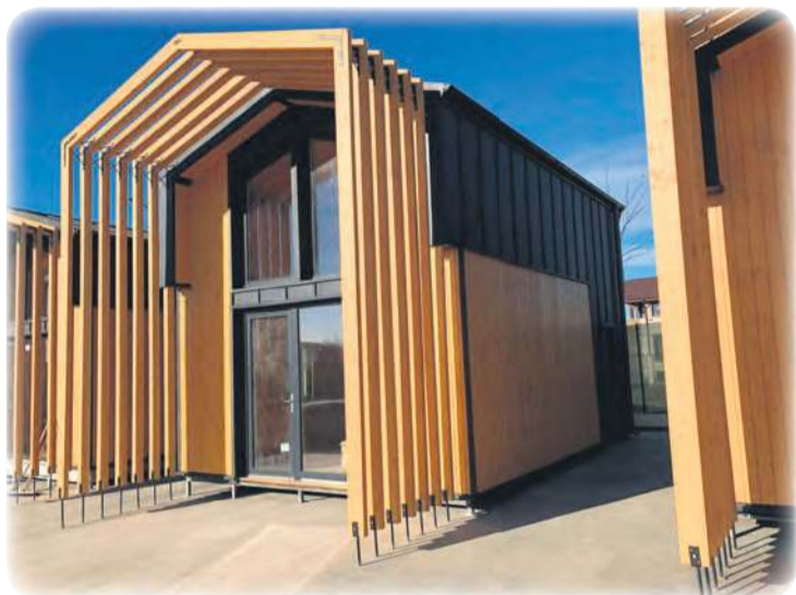
Ten niepozornie wyglądający dom ma 70 m 2 . W podstawowym układzie na parterze jest salon z aneksem kuchennym, sypialnia i łazienka. Na piętrze znajdują się dwa pokoje i druga łazienka.
