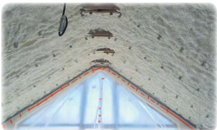
Piana PUR tworzy szczelną warstwę bez mostków termicznych – miejsc, którymi ciepło mogłoby uciekać.
