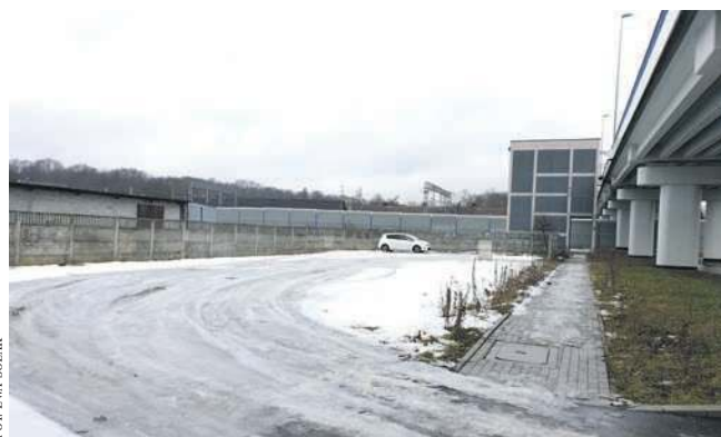
Parking gminny tuż przy samym wiadukcie nieopodal stacji PKP
