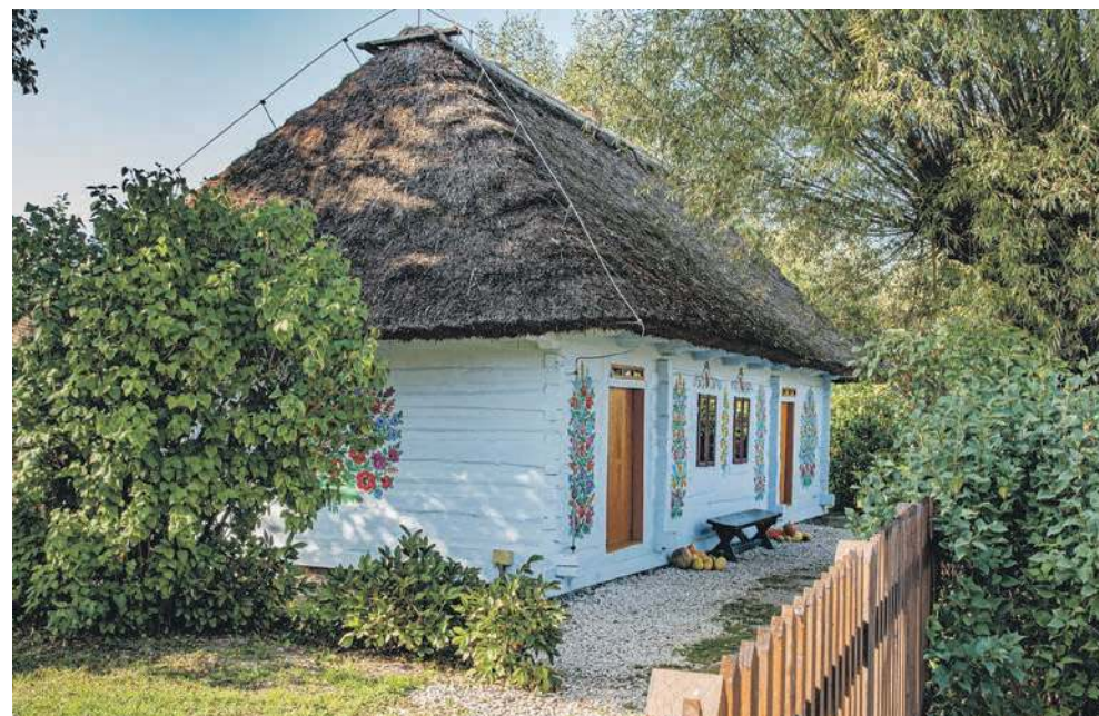
Dom stojący tuż przy zagrodzie Felicji Curyłowej
