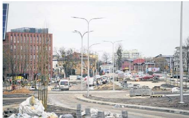
Budowa trasy staromostowej między ulicą Dekerta a Czerwoną Drogą - stan na połowę grudnia 2025 roku
