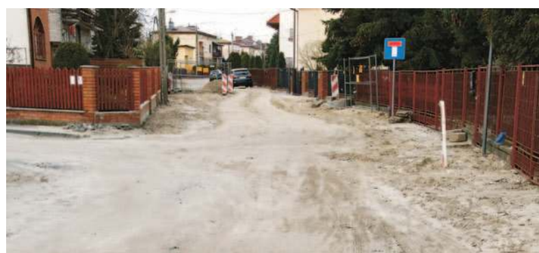
W ramach zadania przebudowy ulicy Krzywej, remontu doczeka się również ulica Wędkarska
