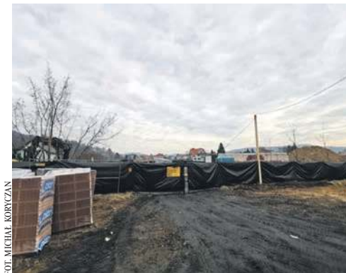
Trwa budowa nowego ośrodka zdrowia w Zagórzcu
