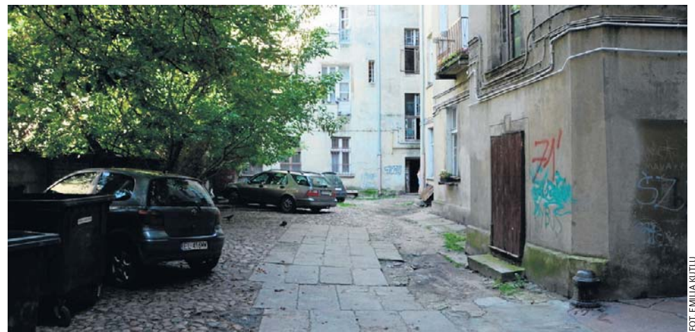
Stan podwórka kamienicy też pozostawia sporo do życzenia.
