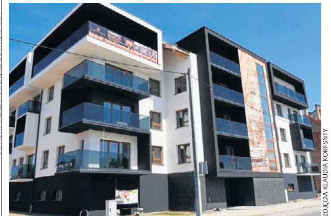
Budynek powstaje w dwóch etapach u zbiegu ulic Fabrycznej i Rzemieślniczej
