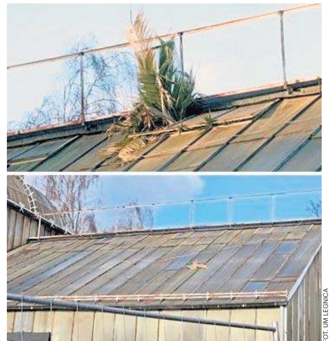
Po naszej interwencji wykonawca remontu palmę zabezpieczył, a okno dachowe zamknął
