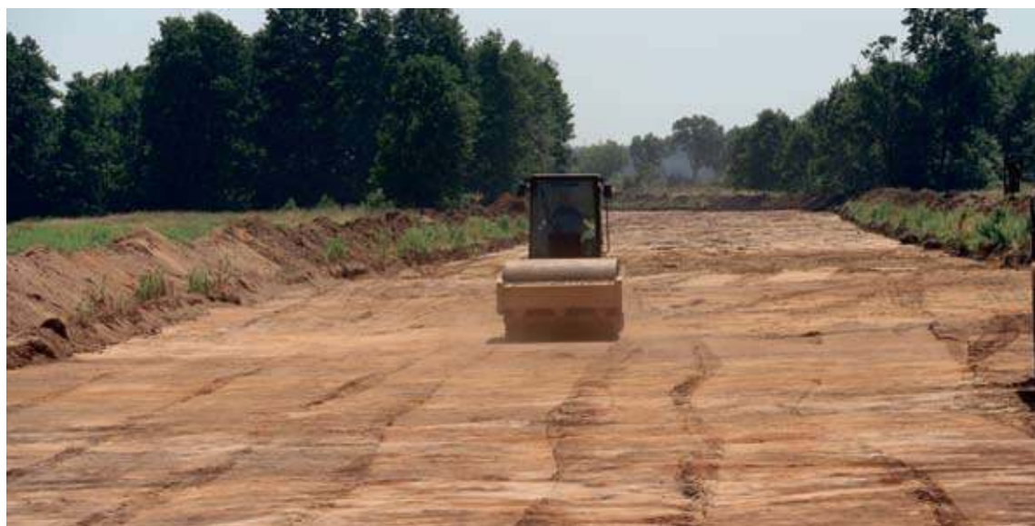
Prace przy budowie drogi zaczęły się w czerwcu. Za rok od tego terminu mają się zakończyć (fot. UM Nowa Sól)
