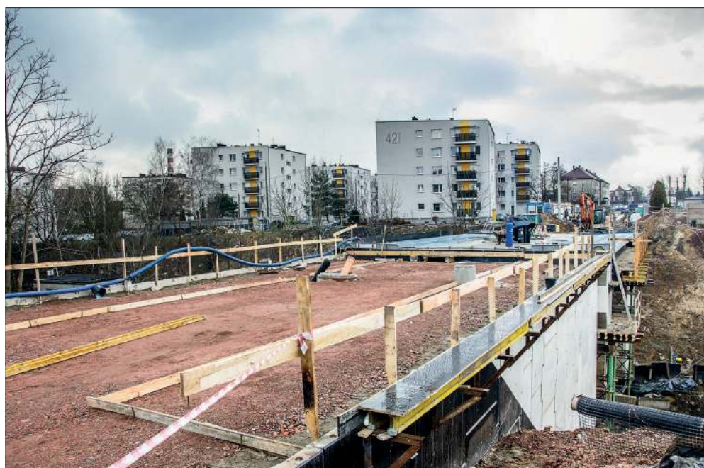
Jak mówi nam rzecznik prasowy radlińskiego urzędu miasta Marek Gajda, prace budowlane na wiadukcie postępują sukcesywnie i są cały czas realizowane. Trwają właśnie rozmowy z wykonawcą odnośnie wyznaczenia nowego terminu zakończenia prac. Niekończąca się opowieść trwa w najlepsze.
