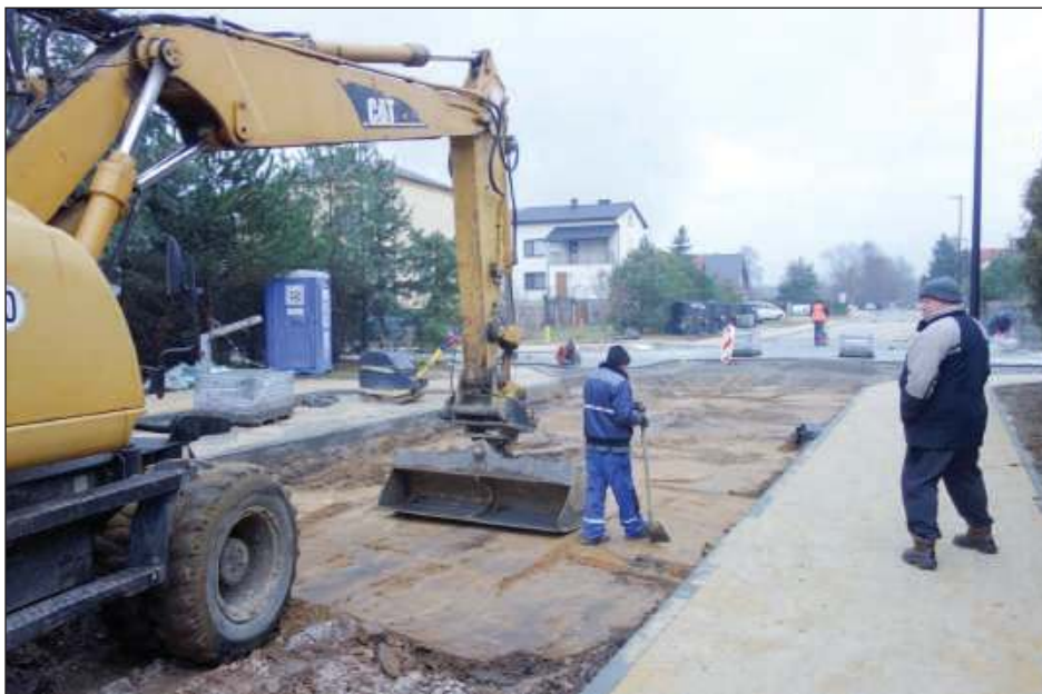
Na ul. Królewskiej trwają prace związane z układaniem kostki. Chodniki już są
