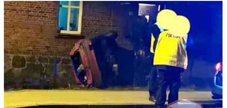
W Witkowie niezany sprawca wjechał w budynek mieszkalny. Nikt nie został poszkodowany. Foto.Stojq!Stargard
