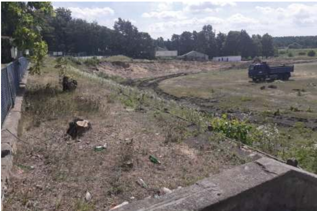
Na nowym stadionie zostanie też zainstalowany specjalny drenaż, budowa potrwa do końca roku (fot. Stoczek Łukowski)
