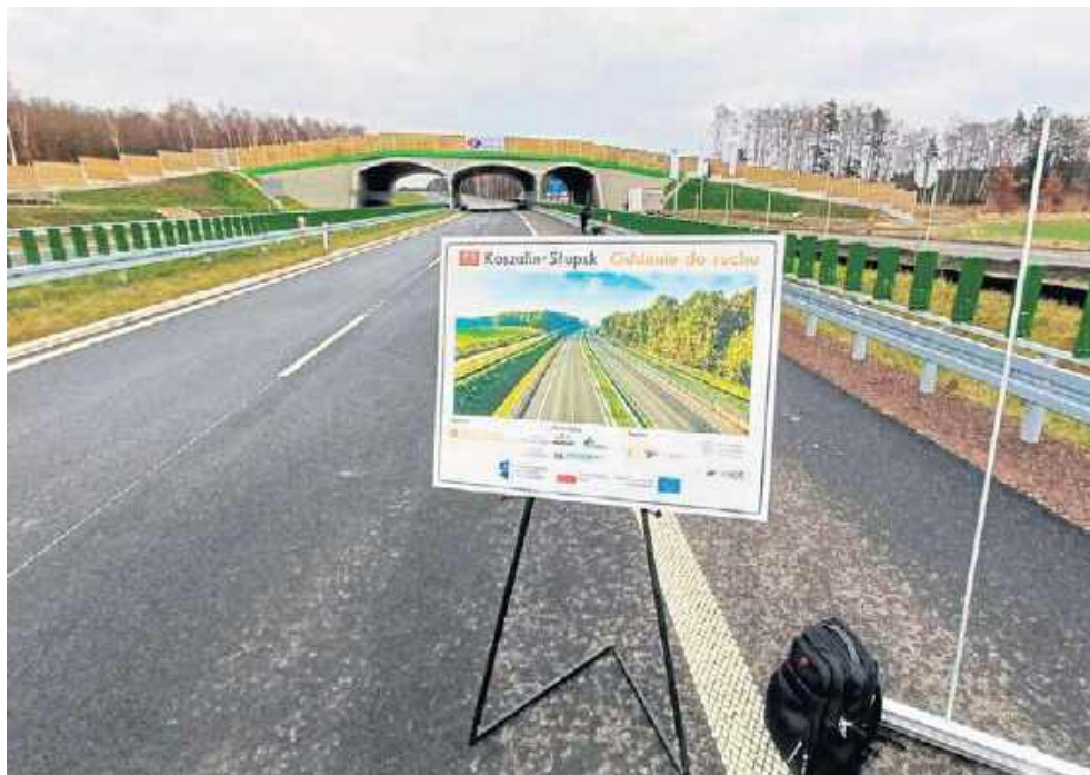
Oddane do ruchu odcinki drogi S6 Sławno - Słupsk i Sianów - Sławno łącznie mają 46 km długości. To świetne wiadomości dla kierowców przed świętami
