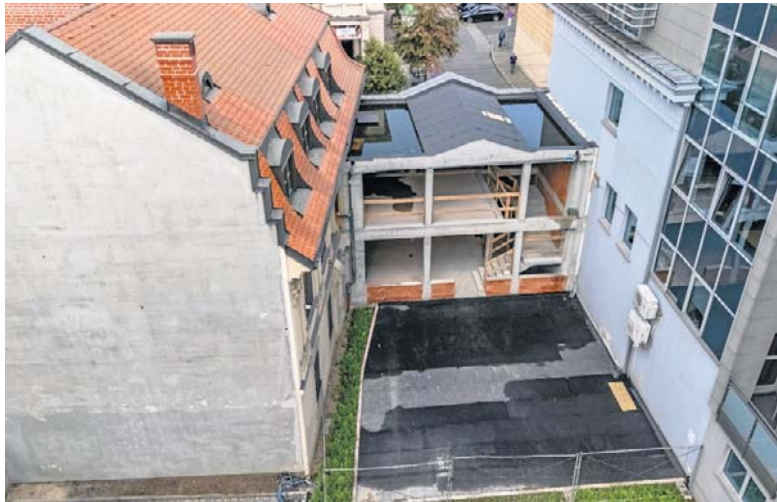
Nowy obiekt dostawiony do oryginalnej ściany frontowej
