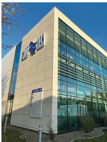
Budynek pogotowia WOD-KAN w Olsztynie
