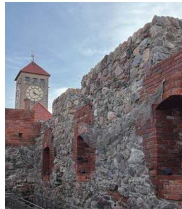
Zabezpieczenie Ruin Zamku Krzyżackiego w Szczytnie
