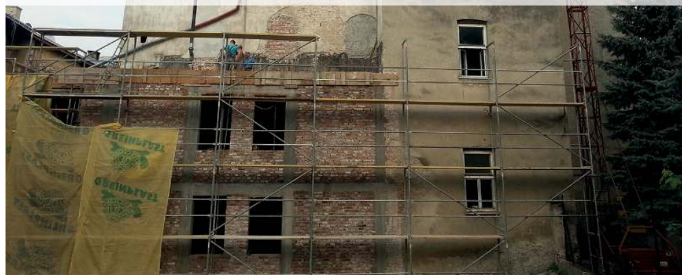
▲ Західна частина Народного дому в час ремонту
