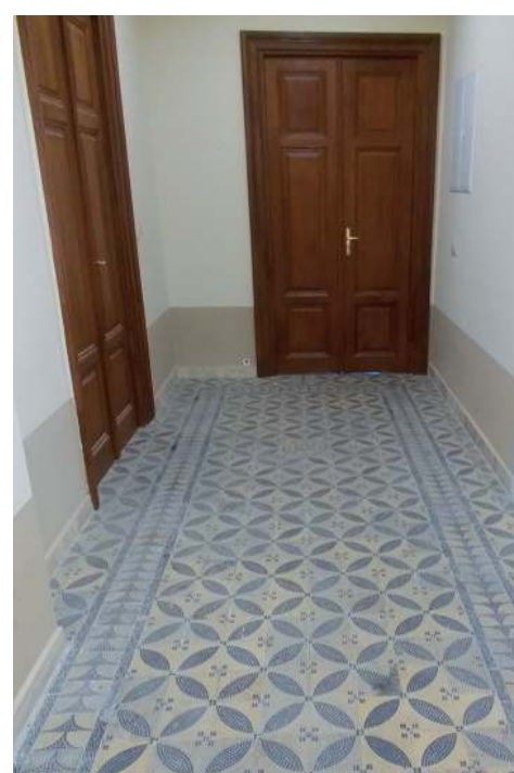
▲ Фрагмент коридору після ремонту
