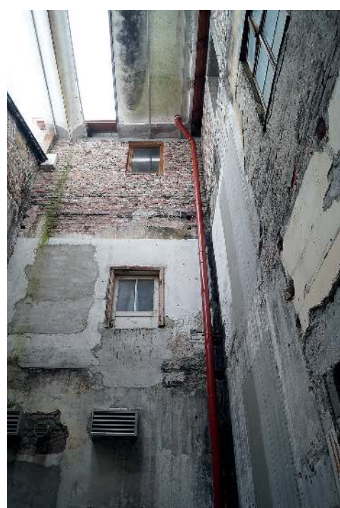
▲ Внутрішнє подвір'я до ремонту
