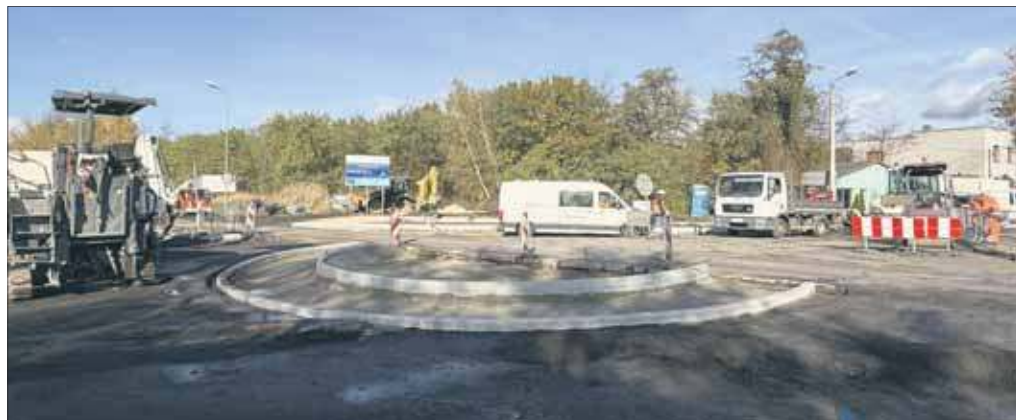
Budowa ronda na DK 79 w Jaworznie
