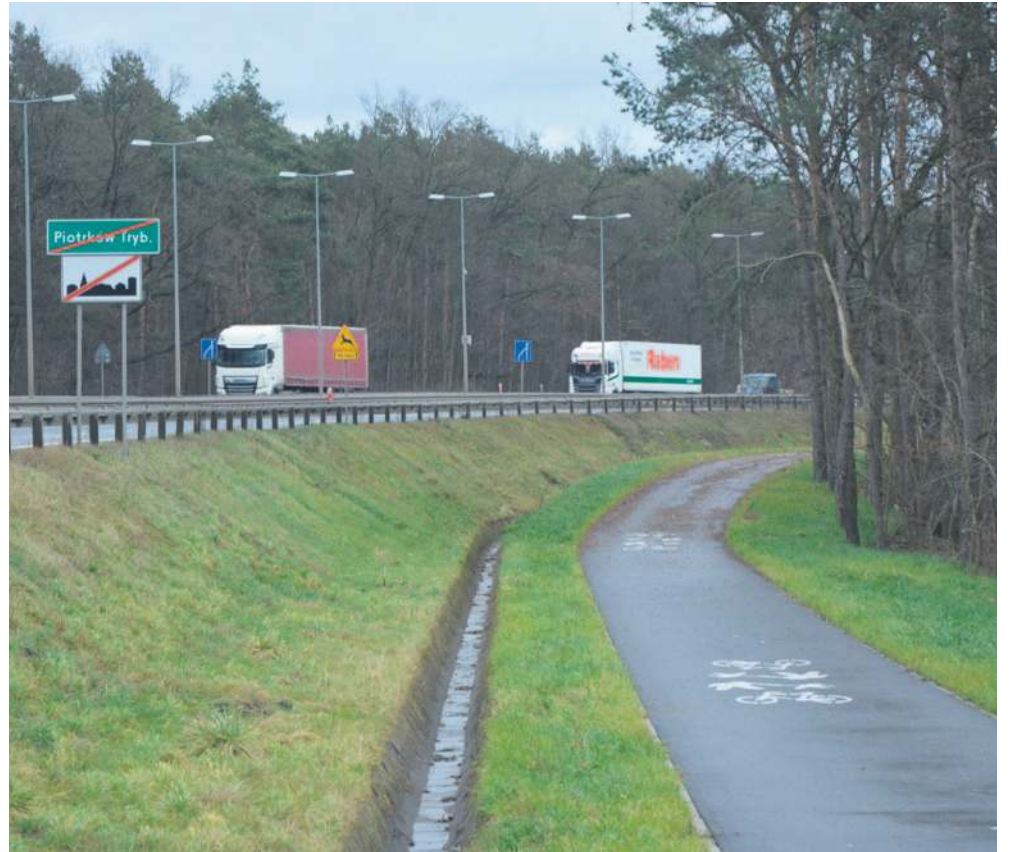
Nowy szlak budowany przez Generalną Dyрекcję Dróg Krajowych i Autostrad w ponad 92% był gotowy w lipcu
