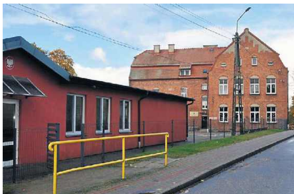
Jedną z lokalizacji, gdzie powstanie miejsce doraźnego schronienia, jest Zespół Szkół w Skorzewie. Na 2026 rok zaplanowano opracowanie dokumentacji
