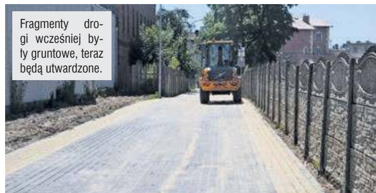
Na drodze ułożona jest betonowa kostka.
