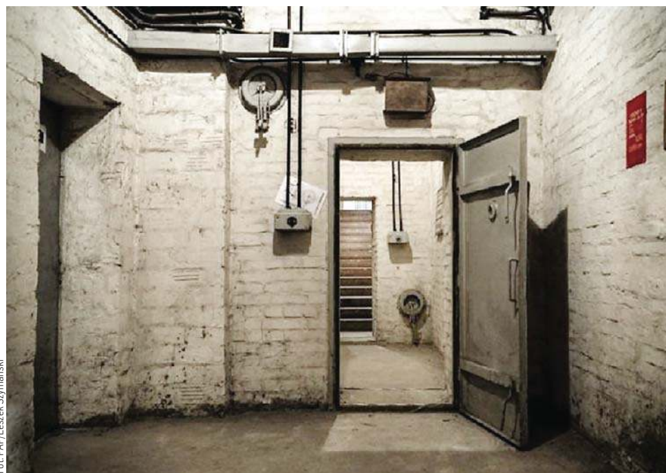
Stary schron w budynku użyteczności publicznej
