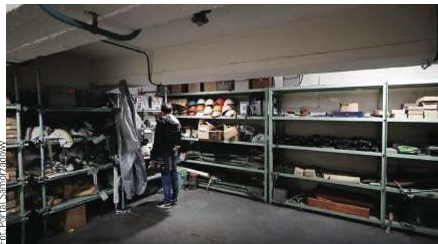
Na zdjęciu schron, stanowisko dowodzenia obrony cywilnej pod budynkiem biurowym ArcelorMittal Huty Warszawa
