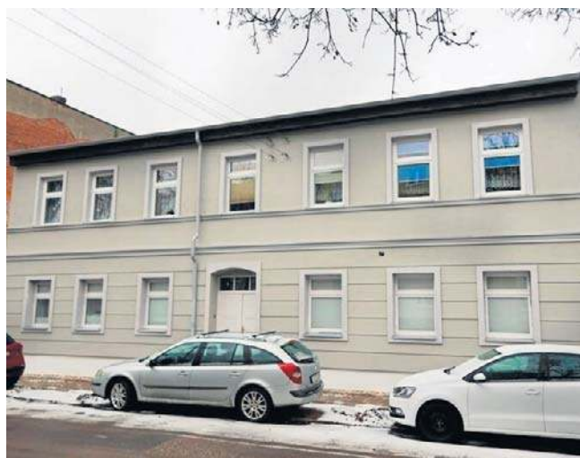
Popielatą fasadę budynku przy ul. Leszczyńskiego 14 po remoncie zdobiją jaśniejsze gzymsy i opaski wokół okien
