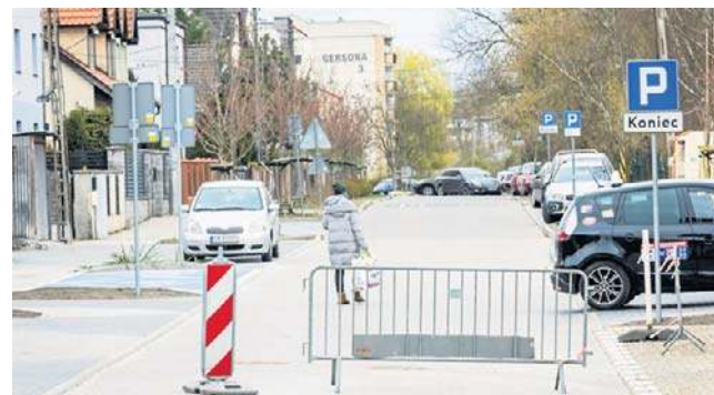
Ponad 36 milionów złotych zostanie przeznaczonych w 2026 roku na bydgoski program utwardzania ulic
