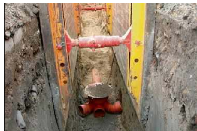
Pieniądze przeznaczone będą na rozbudowę sieci kanalizacyjnej w gminie.
