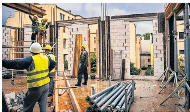
Firma KWK Construction ma zakończyć prace w 2024 r.
