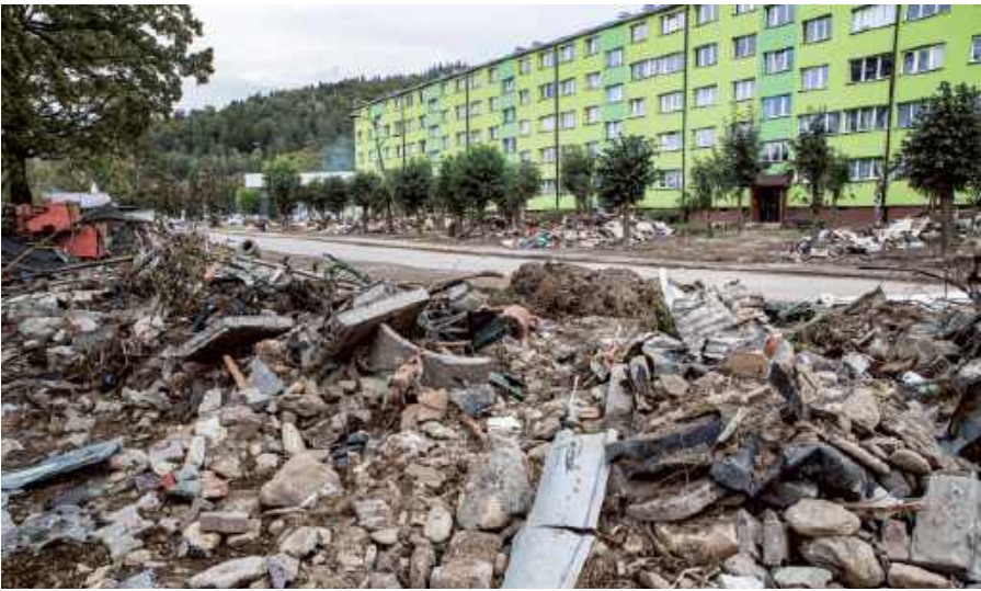
Na ulicach zalanych miasteczek zalegają tony gruzu.
