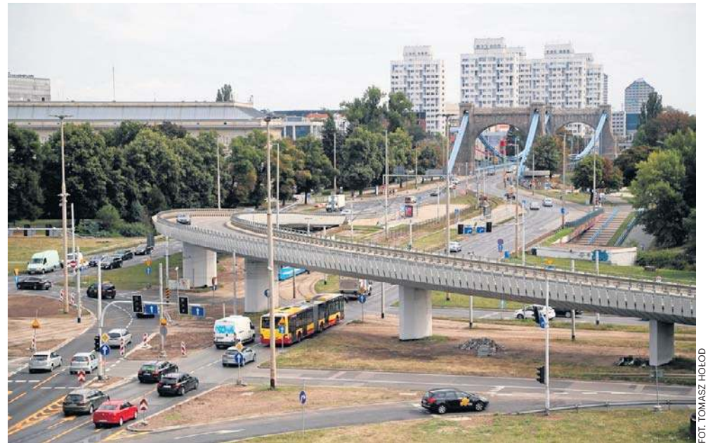
Estakada prowadząca z Mostu Grunwaldzkiego w stronę ul. Traugutta będzie wyburzona
