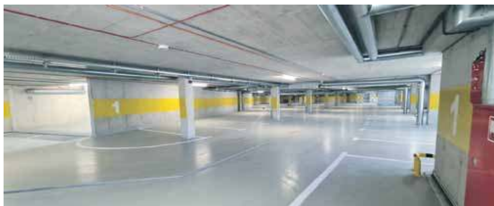
Tak wygląda pierwszy parking w Zakopanem, który składa się z trzech poziomów.
