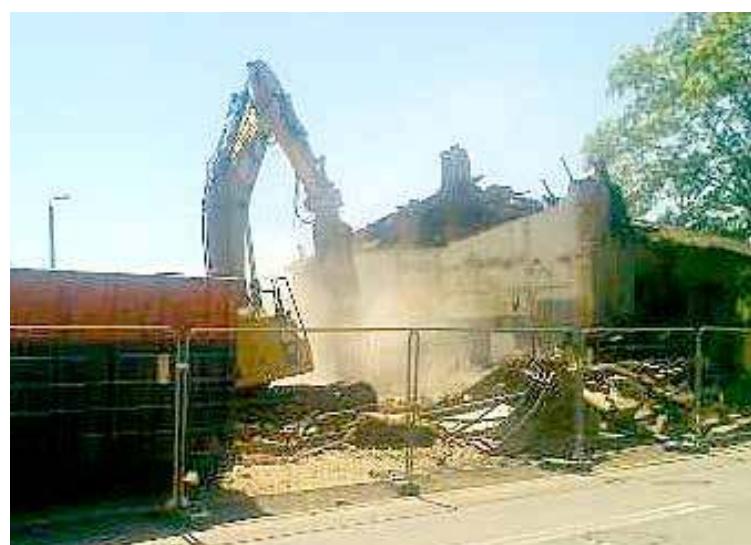
Prace rozbiórkowe przeprowadzono w poniedziałek
