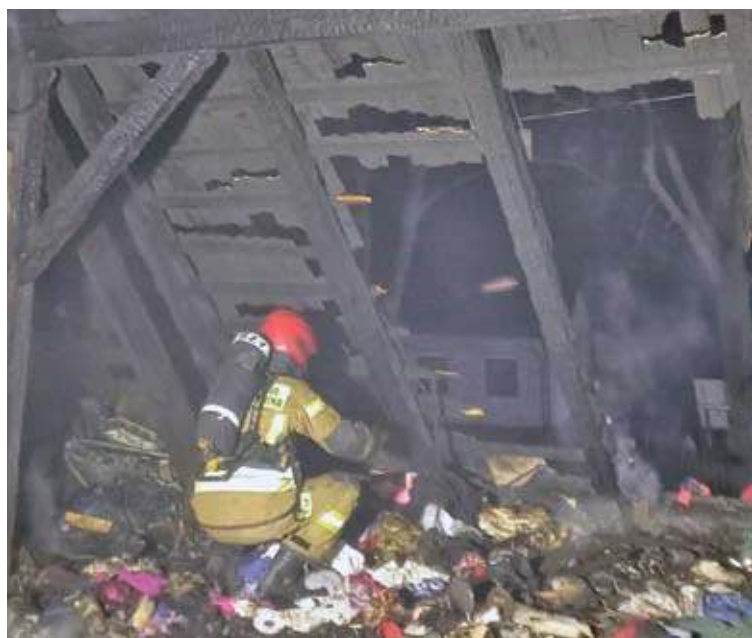
Tak wyglądało poddasze po zakończeniu akcji strażaków (fot. PSP Nowa Sól)
