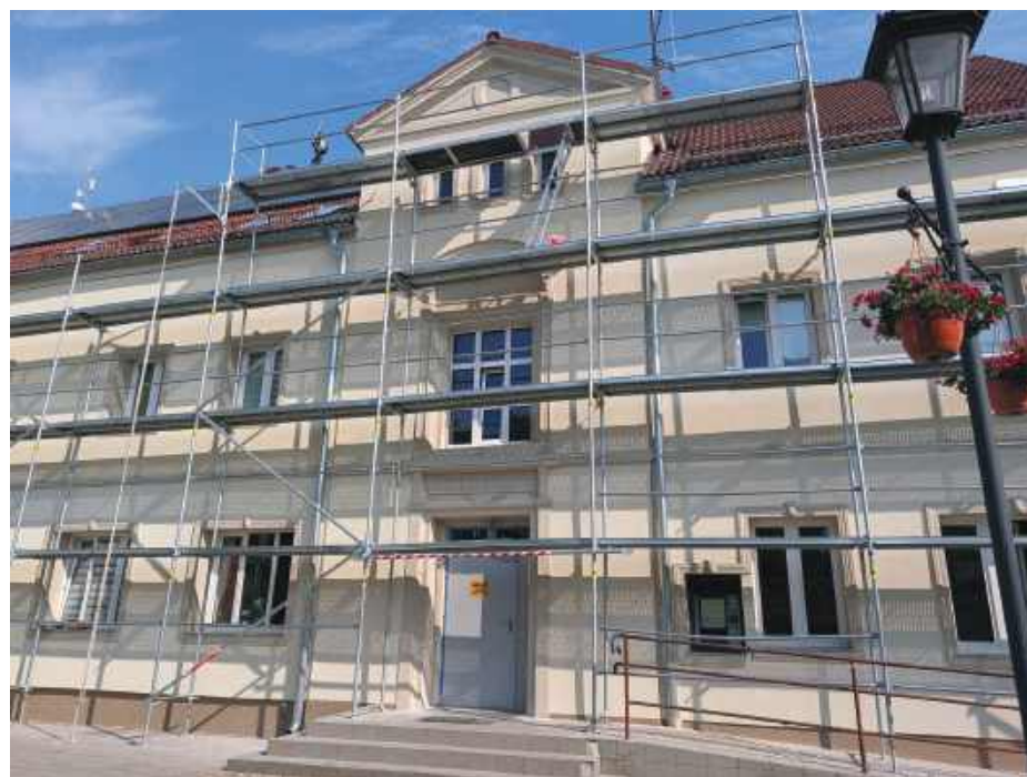
Jasnobieżowa elewacja i ozdobne detale to najbardziej widoczne efekty modernizacji
