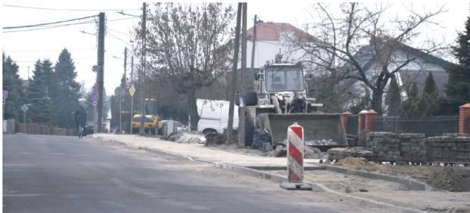
Mieszkańcy ulicy Kościuszki narzekają na wydłużone prace remontowe oraz hałas przejeżdżających ciężarówek. Do sprawy szybko odniósł się burmistrz miasta, Zbigniew Kot
