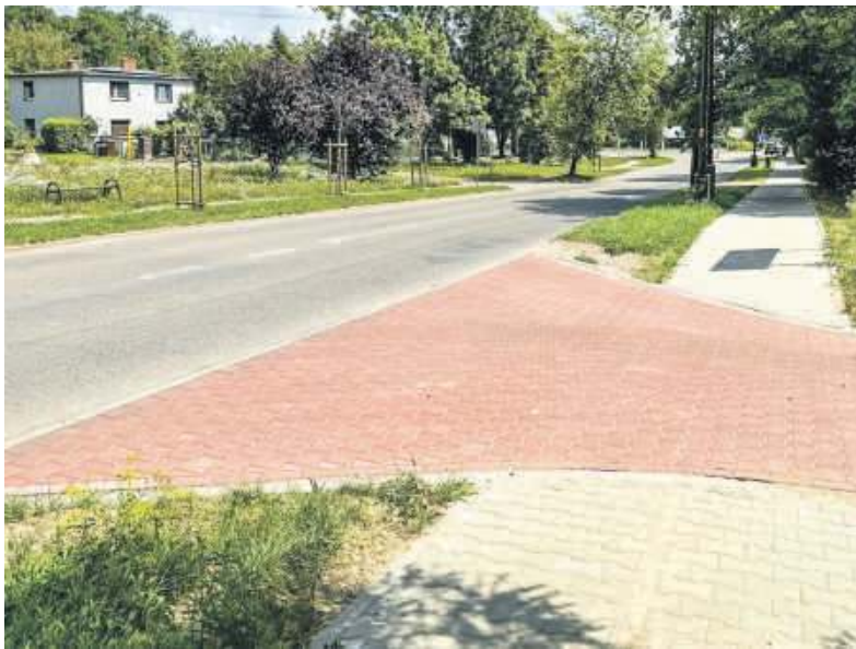
Po remoncie chodniki są równe jak stół
