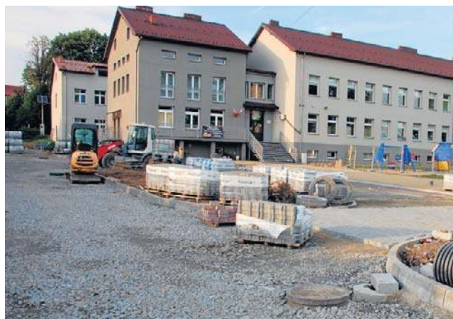
Koszt budowy miejsc postojowych „kiss&ride” to ponad 900 tysięcy złotych
